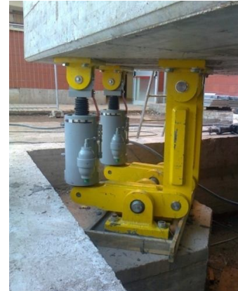
La realizzazione delle torri ed un particolare del manovellismo con dissipatore
