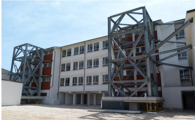
La realizzazione delle torri ed un particolare del manovellismo con dissipatore
